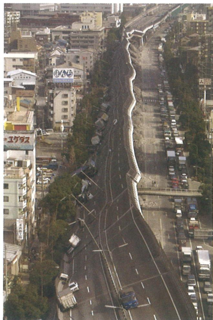
阪神・淡路大震災で横倒しとなった橋脚 阪神地方を襲ったマグニチュード7.3、震度7の大地震で、死者は6400人をこえた。
