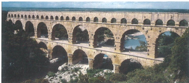
ローマ時代の水道橋(上) 前1世紀末に建設されたガール水道橋(南フランス)。全長270m、高さ50mの石造。ローマの土木技術の高い水準を示す好例。
