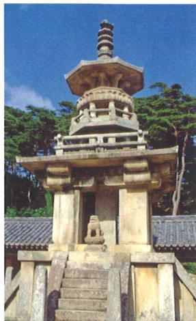
ぶつこくじ たほうとう 仏国寺の多宝塔 仏国寺は新羅の時代に建立された。塔は石造で、精巧な手法でつくられている。韓国、慶州。
