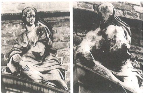
酸性雨 さんせいりゅう の影響でとけた石像 左は1908年、右は69年のもの。硫酸 いおう 酸化物や窒素 ちつそ 酸化物などの大気汚染物質を含む酸性雨は、土壌・水質や建造物にも影響を与えている。
